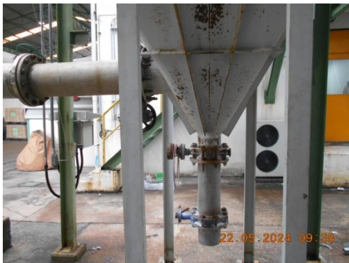
รูปที่ 3 Bag Filter ในระบบบำบัดแก๊สไนลอน
