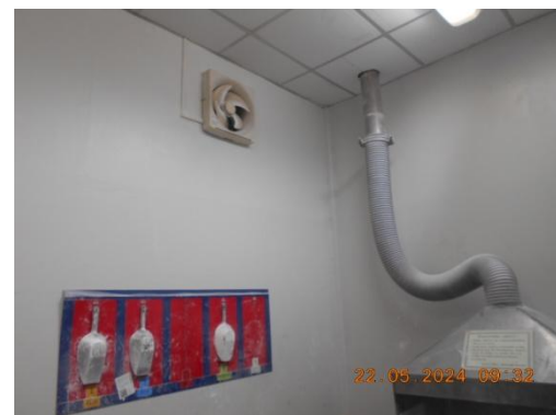
รูปที่ 32 พัดลมดูด AH Salt ออกนอกอาคารผลิต
