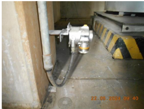
รูปที่ 23 Gas Detector
