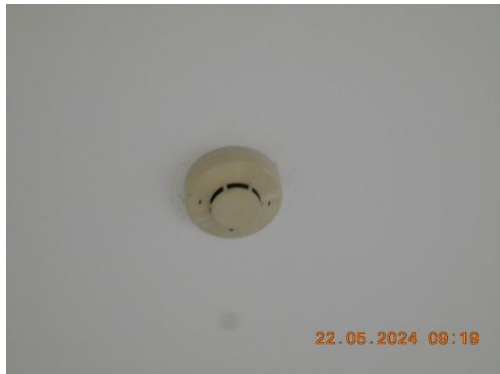
รูปที่ 29 Smoke Detector
